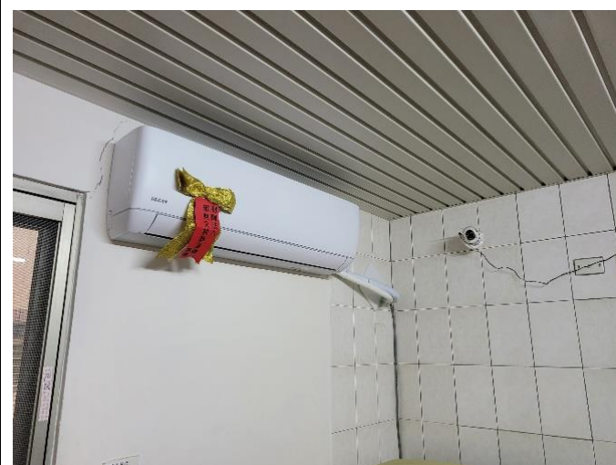
捐贈的變頻冷氣已安裝完成
